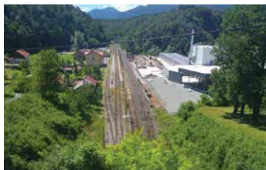
Pilana Cedar sa svojim postrojenjem za proizvodnju pare i električne energije
