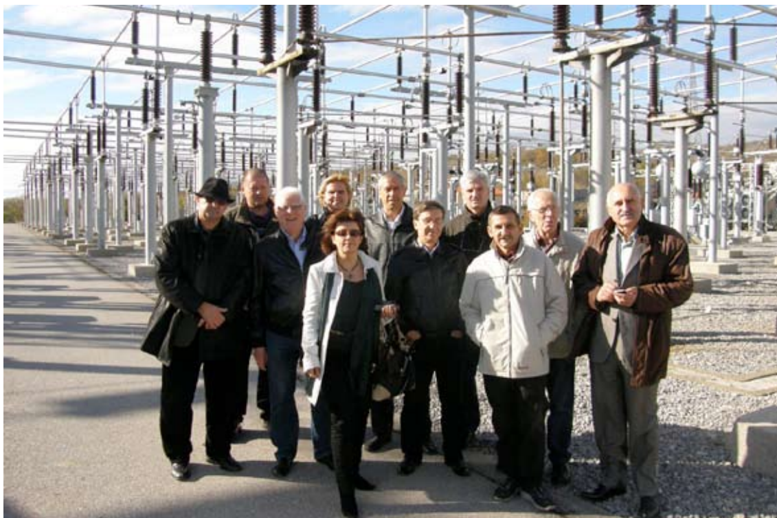
Posjet UO HKIE trafostanicama Turnić i Meline u organizaciji PO Rijeka
